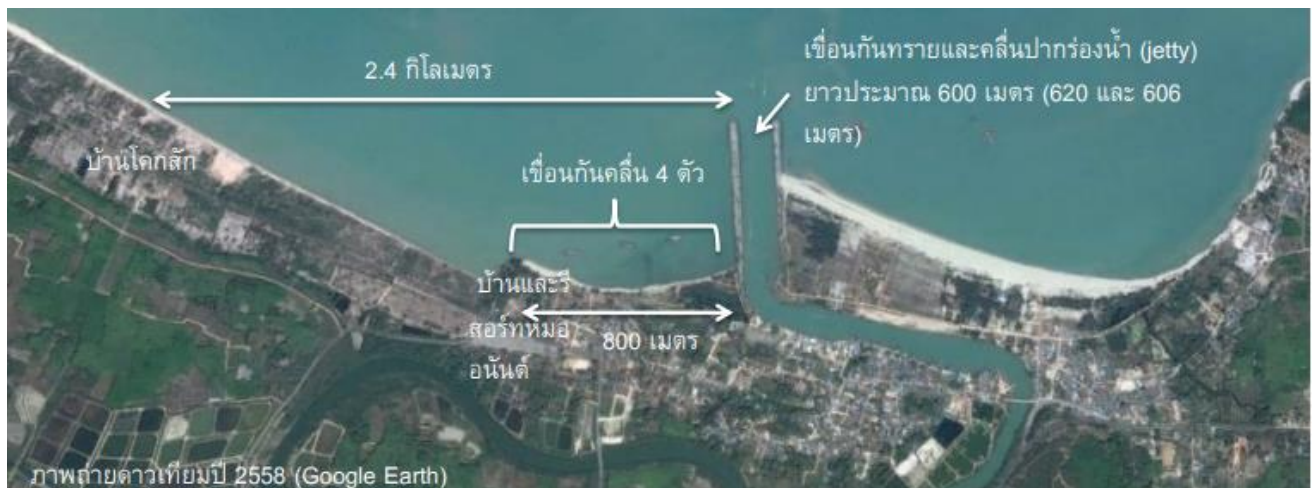
รูปที่ ก.3 ภาพถ่ายดาวเทียมแสดงโครงสร้างทางวิศวกรรมชายฝั่งทะเลพื้นที่หาดสะกอม
